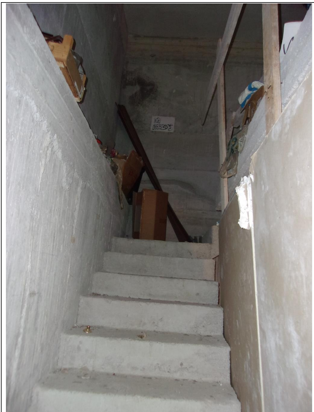
Foto n. 53 scala di accesso al piano superiore
