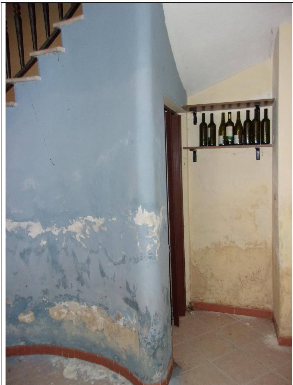
Foto n. 13 locale cisterna –piano terra
