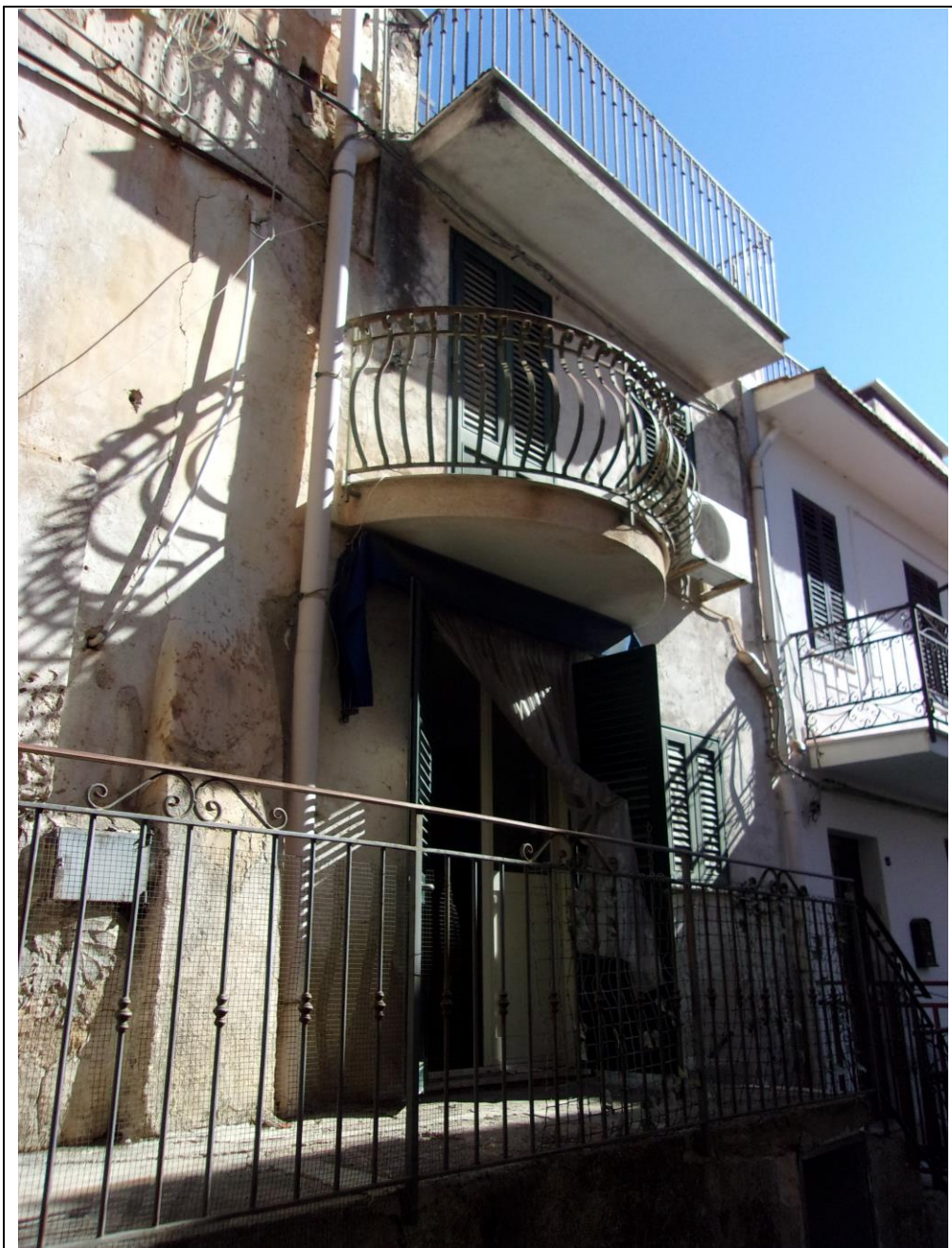
Foto n. 7 ingresso civico 13 appartamento
