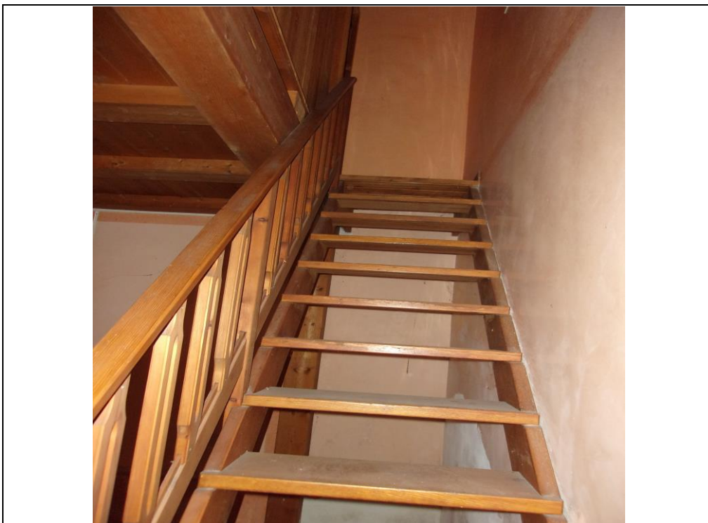
Foto n. 44 scala di accesso al soppalco
