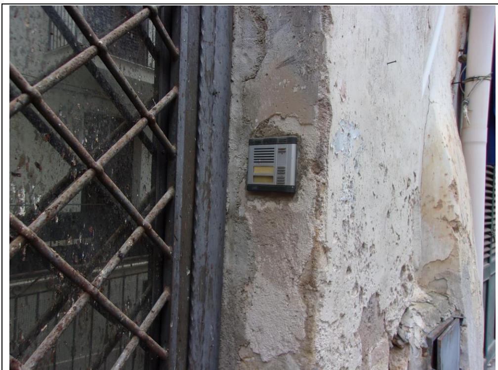
Foto n. 33 ingresso civico 11 appartamento
