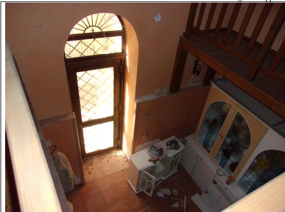
Foto n. 48 veduta dal soppalco su piano terra
