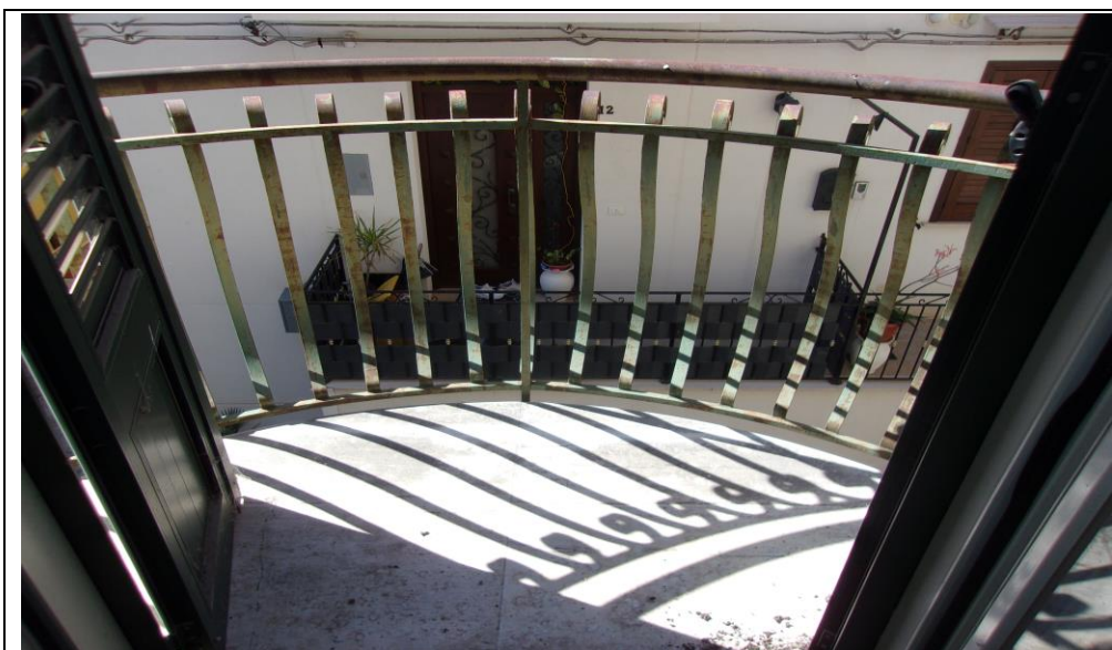
Foto n. 29 Balcone ammezzato-primο piano
