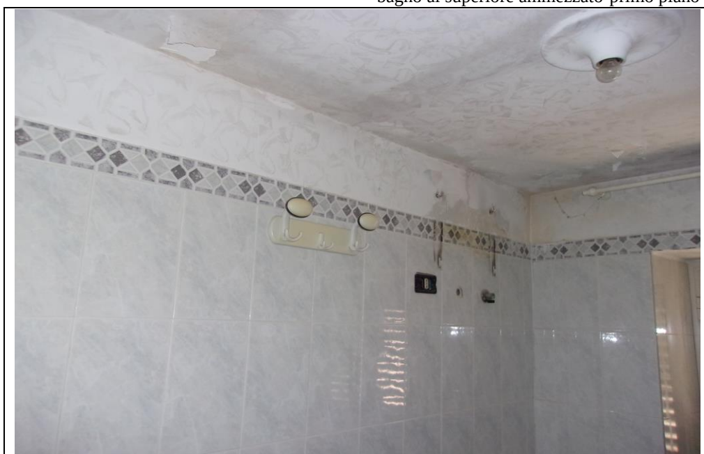
Foto n. 26 bagno al superiore ammezzato-prim piano
