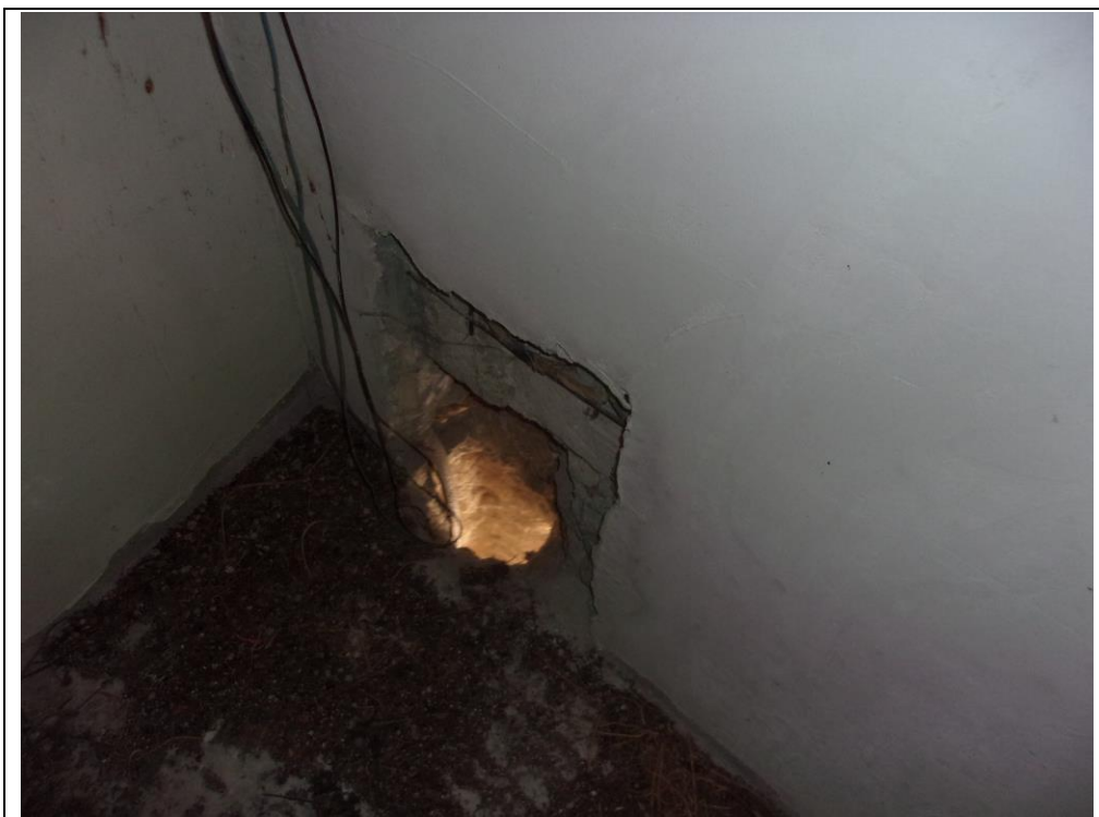
Foto n. 57 piano superiore deposito Scavo per predisposizione nuovi impianti
