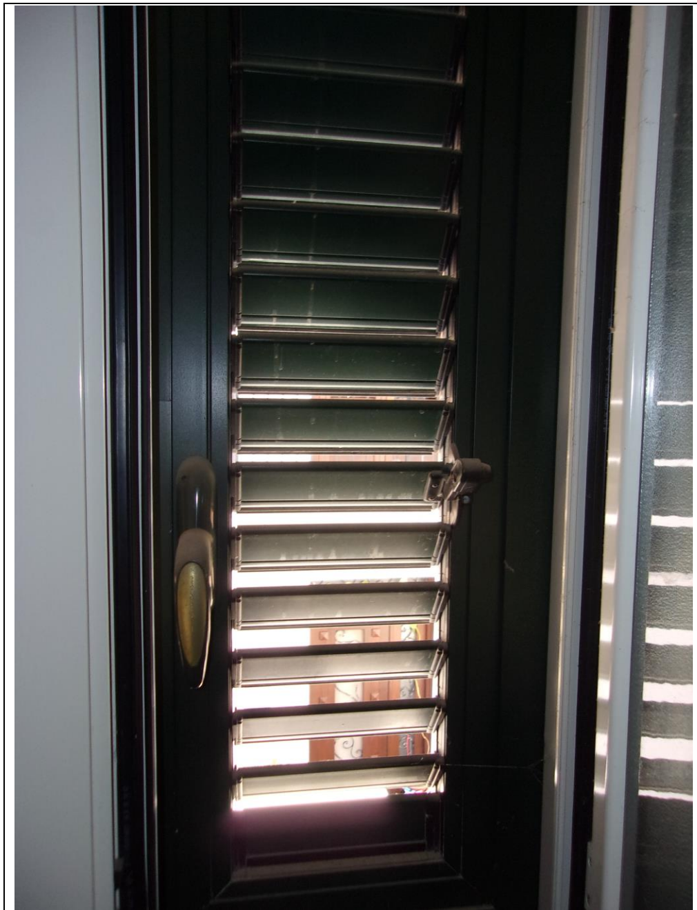
Foto n. 27 Tipologia di infissi eterni ammezzato-primo piano
