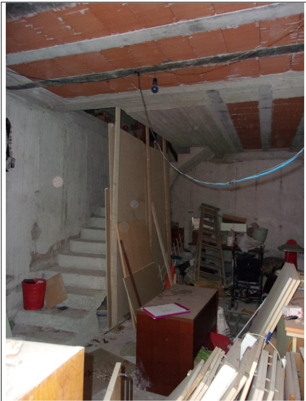
Foto n. 52 piano terra magazzino deposito
