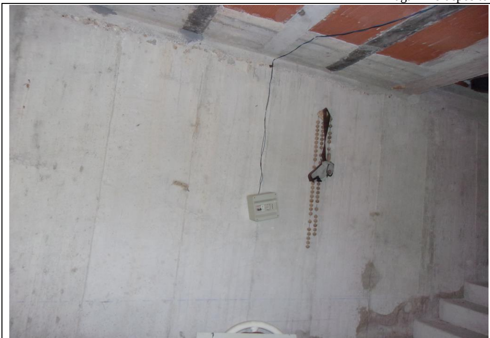
Foto n. 51 piano terra magazzino deposito
