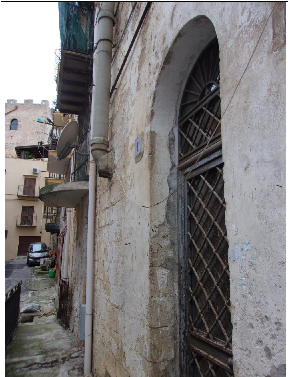
Foto n. 32 ingresso civico 11 appartamento
