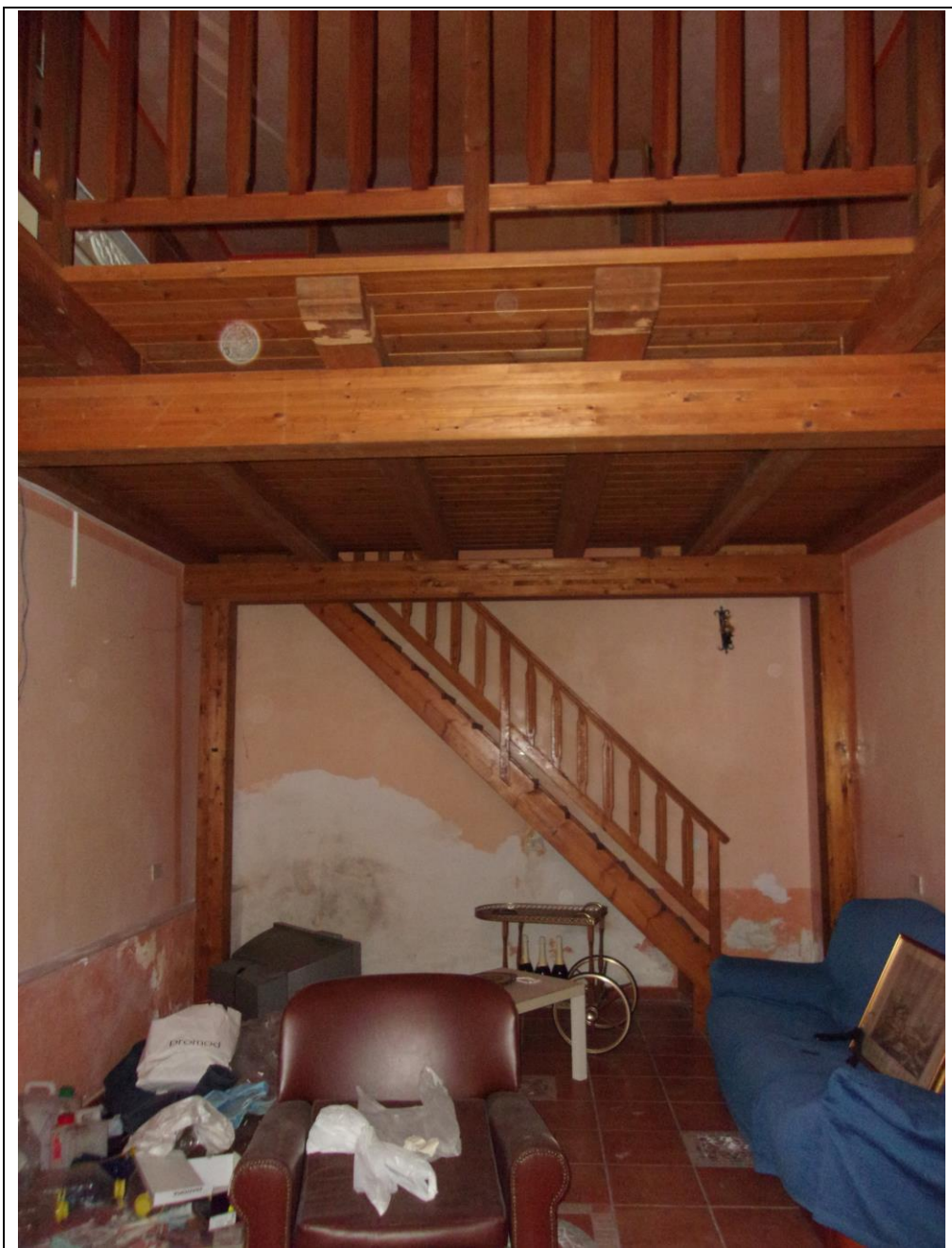
Foto n. 39 interno piano terra
