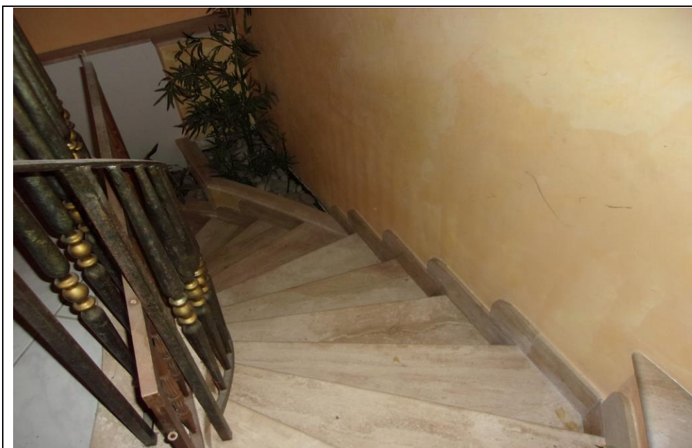
Foto n. 20 Scala di accesso al superiore ammezzato-primo piano
