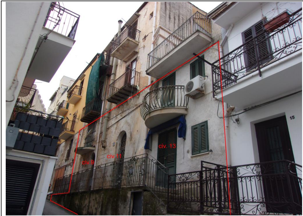
Foto n. 1 prospetto dell'intero immobile su Via Ludovico Ariosto
