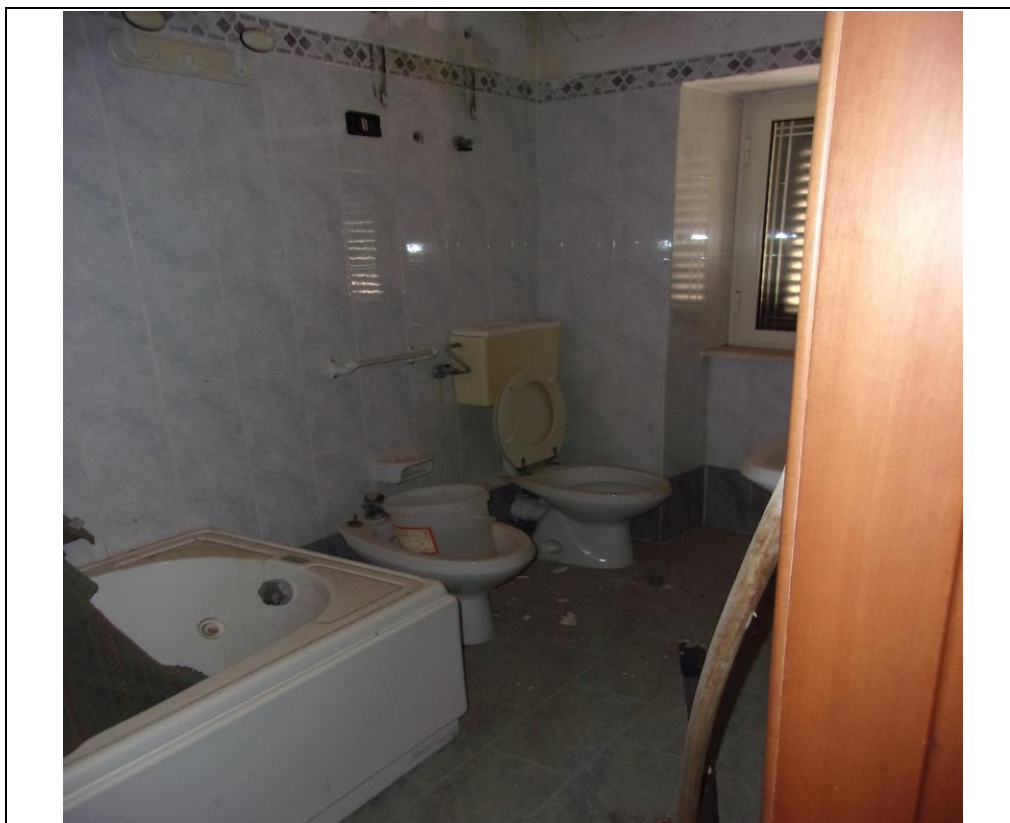
Foto n. 25 bagno al superiore ammezzato-prim piano
