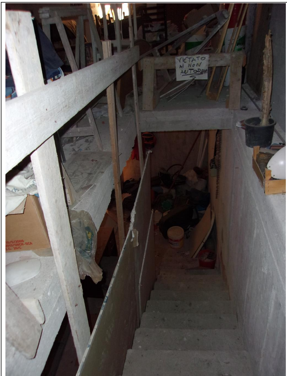
Foto n. 54 scala di accesso al piano superiore
