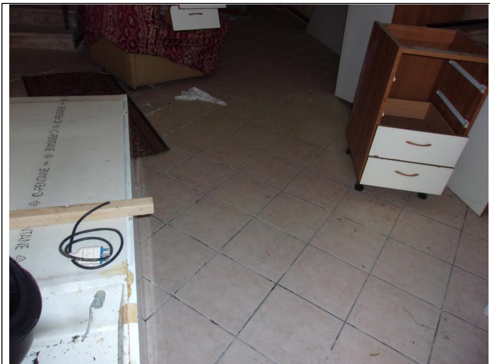
Foto n. 12 pavimentazione –piano terra
