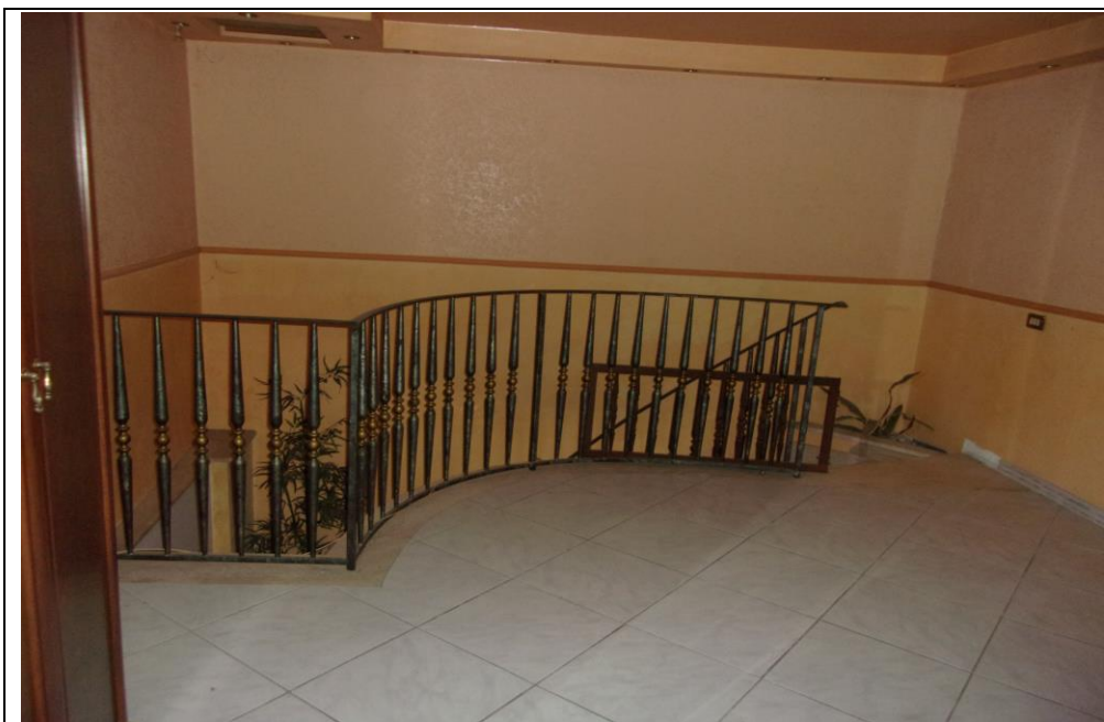
Foto n. 19 Scala di accesso al superiore ammezzato-primo piano
