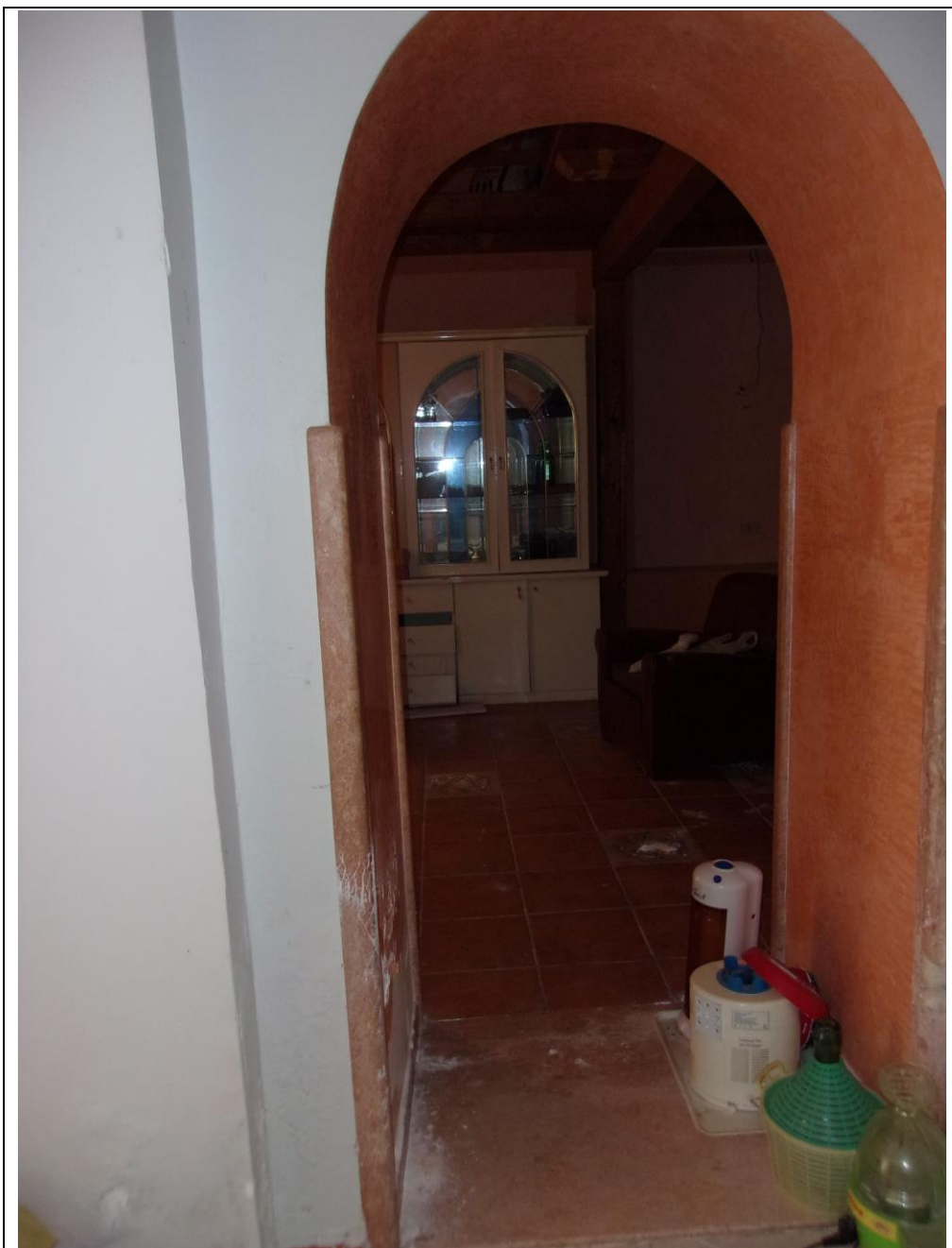
Foto n. 35 varco di accesso dall'adiacente civico 13 (cucina soggiorno)
