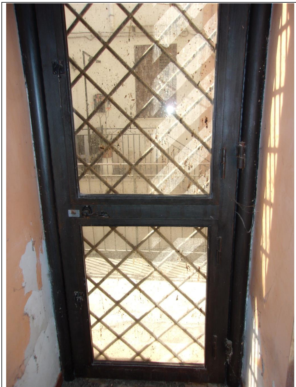
Foto n. 34 ingresso civico 11 Interno appartamento
