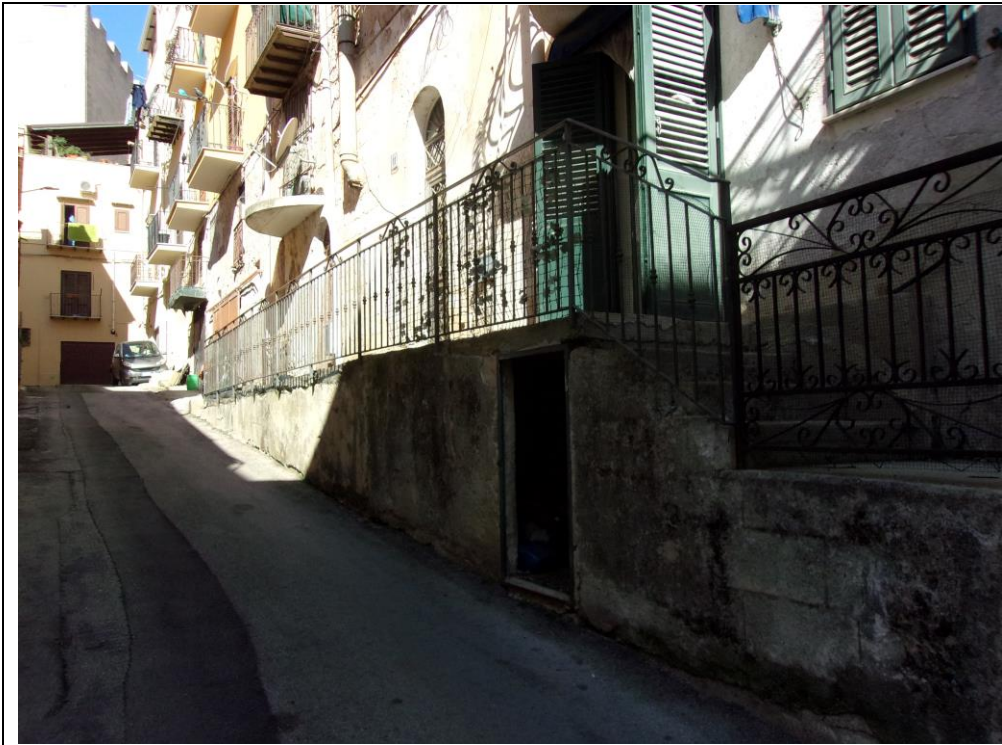
Foto n. 3 ballatoio di accesso esclusivo
